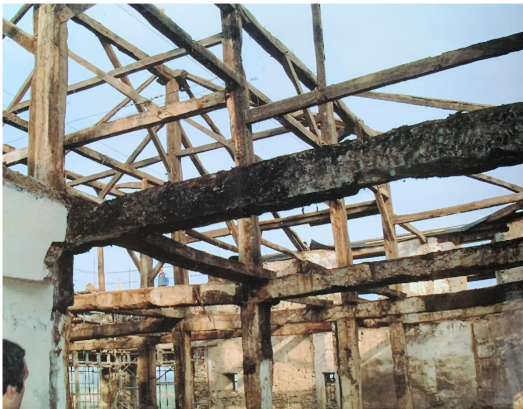
FOTO 3. Obras de restauración del caserío-palacio de Bitain.
