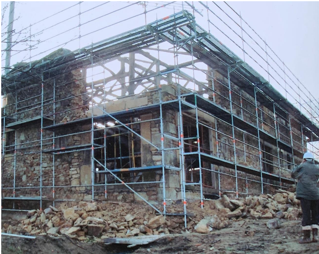
FOTO 2. Obras de restauración del caserío-palacio de Bitaño.
