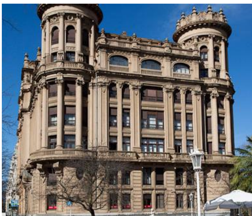
FOTO 33. Casa Ampuero, Gran Vía 58, Bilbao.
